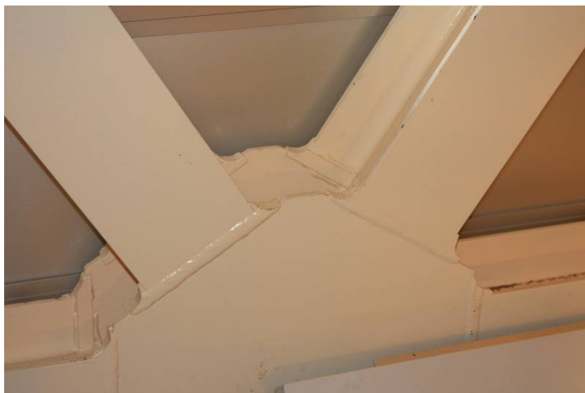
V型支撑下节点
