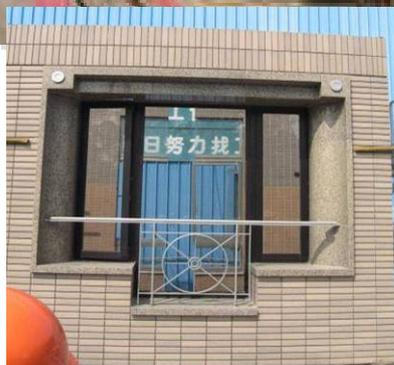
已完成外墙装饰的墙板
