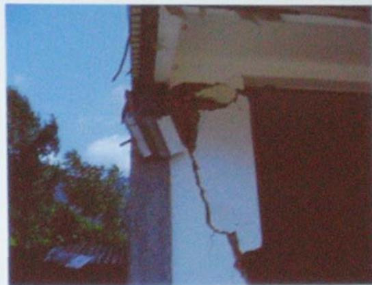
北川县擂鼓镇某厂下岗职工宿舍楼—六层砌体结构，有构造柱和圈梁，裂而不倒。
