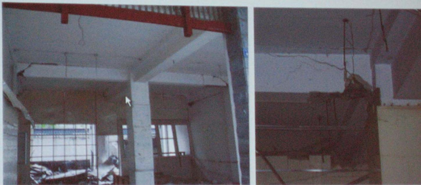
都江堰市某6层底框结构中，底层框架柱再现了强柱弱梁，梁端发生了破坏。
